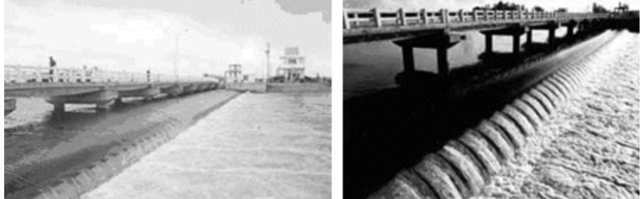
Đập Trà Sư (trái) và đập Tha La (phải)
